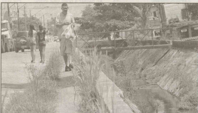
Outro problema é o mato nas calçadas e no canal; população pede providências urgentes
