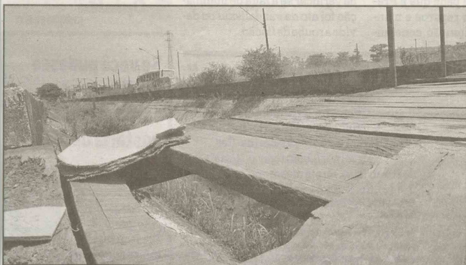
Muitos pontilhões de madeira existentes ao longo da avenida estão com rombos e madeiras podres
