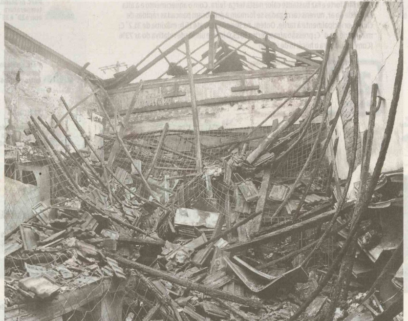
Fogo foi tão intenso que o telhado do estabelecimento acabou desabando. Ninguém ficou ferido
